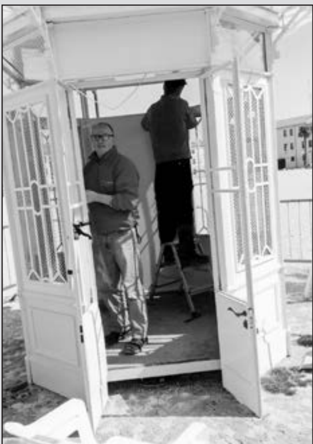
Lavori di ripristino al chiosco
